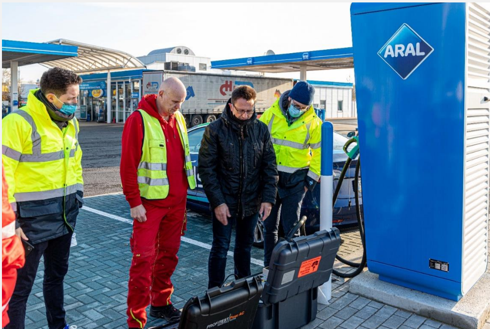
Obr. 9. Zkouška nabíjecí stanice s PROFITEST H+E XTRA a PROFITEST PRIME
